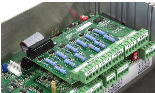
Figura 3-36: Instalação da E/S discreta no gabinete de montagem em painel
